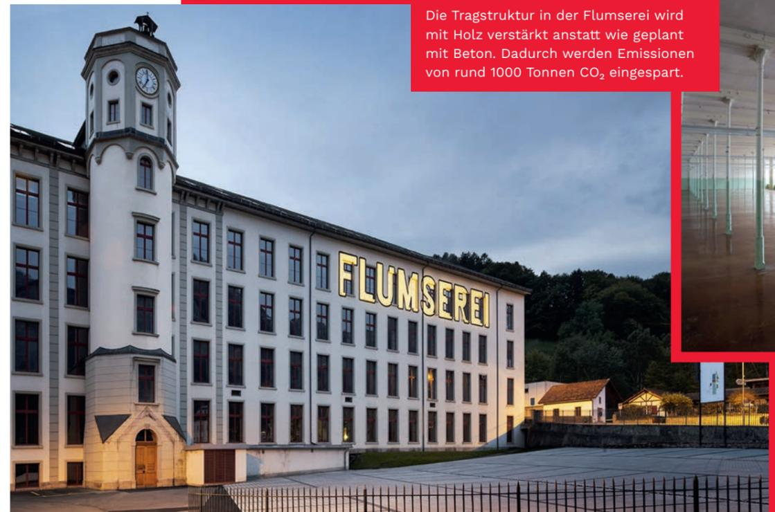
Die Tragstruktur in der Flumserei wird mit Holz verstärkt anstatt wie geplant mit Beton. Dadurch werden Emissionen von rund 1000 Tonnen CO<sub>2</sub> eingespart.
