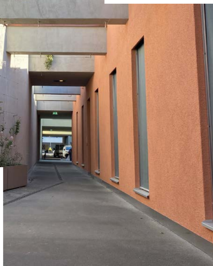
Der Um- und Ausbau des Rietschi-Areals im Hinterhof an der Güterstrasse 246 in Basel zu Wohnungen, Ateliers, Büros und einem Kindergarten ist nun fertiggestellt und bezogen.
