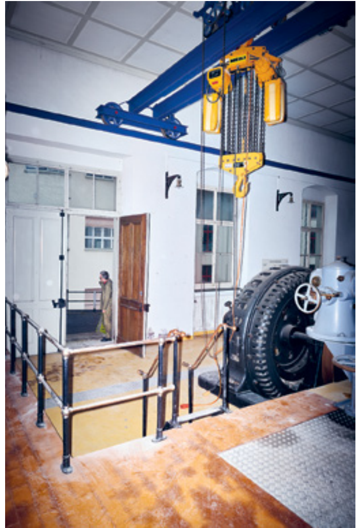
Die mächtigen Generatoren wurden einst durch Wasserkraft angetrieben und brachten die Maschinen der Textilfabrik zum Laufen. Was mit ihnen passiert, steht noch nicht fest. / Autrefois mus par la force hydraulique, les puissants générateurs faisaient tourner les machines de l'usine textile. Leur sort définitif n'est pas encore fixé.
