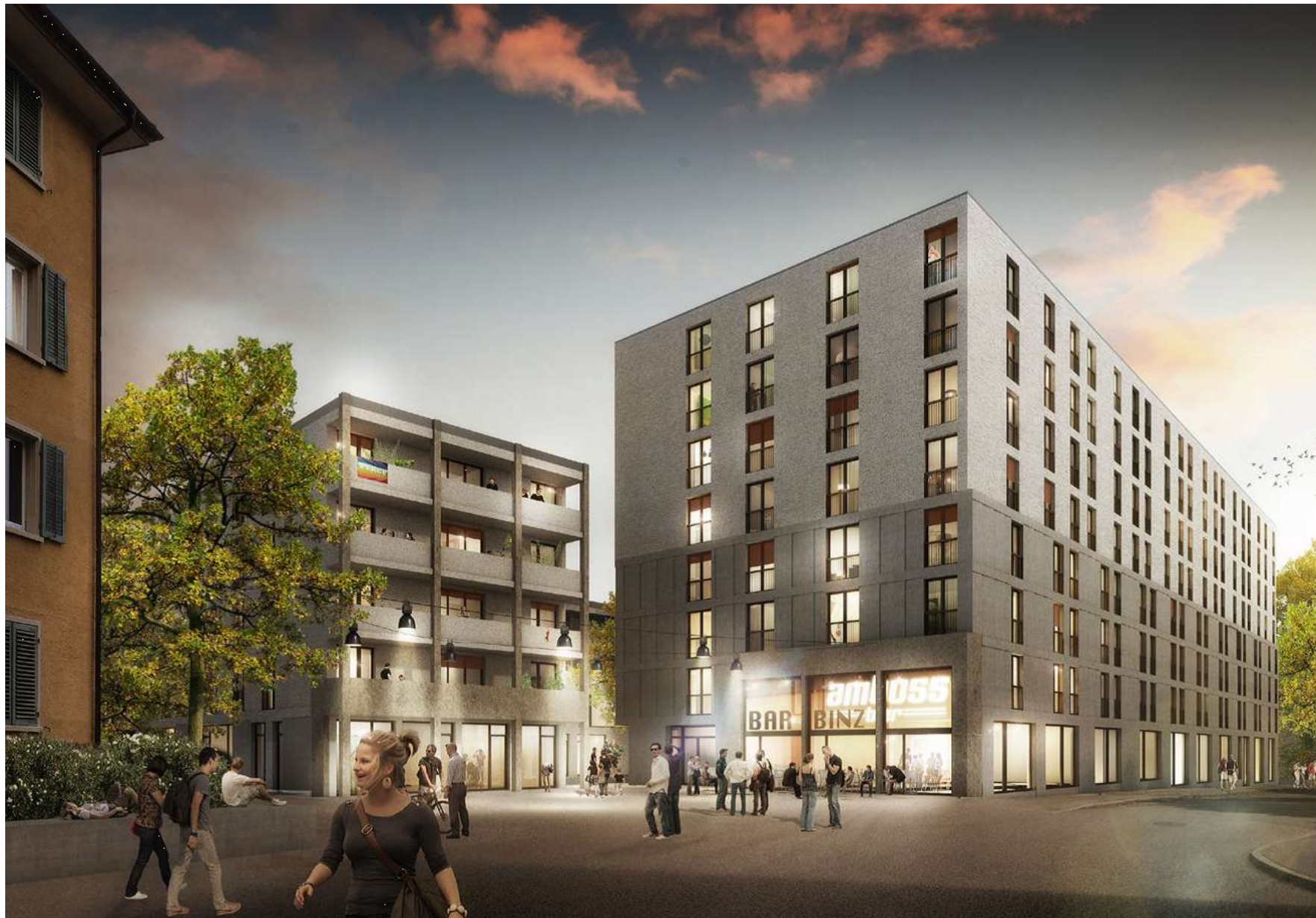
Zürich, Üetlibergstrasse 111 Neubau Wohnhaus für USZ-Personal & Studenten (im Baurecht) Üetlibergstrasse 111 Baujahr 2016-2018
